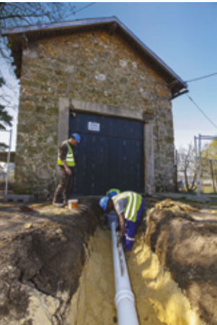
Pose d'un collecteur
