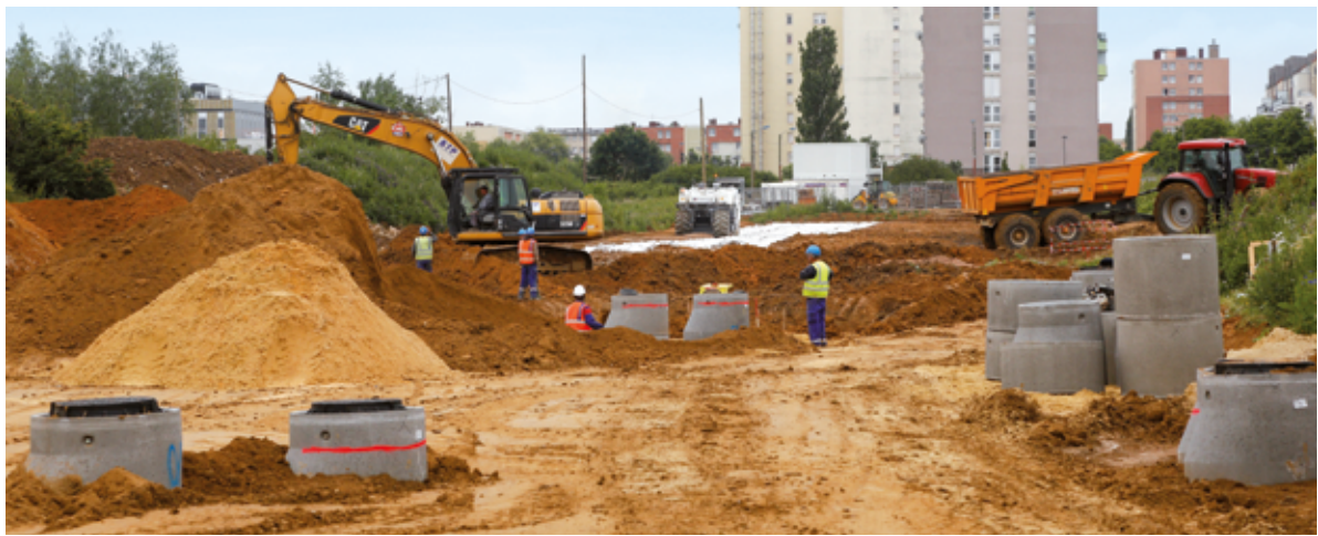
Pose de regards de visite.
