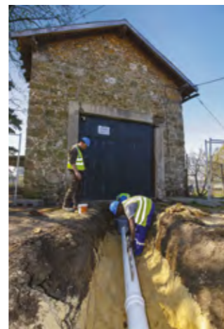
Pose d'un collecteur
