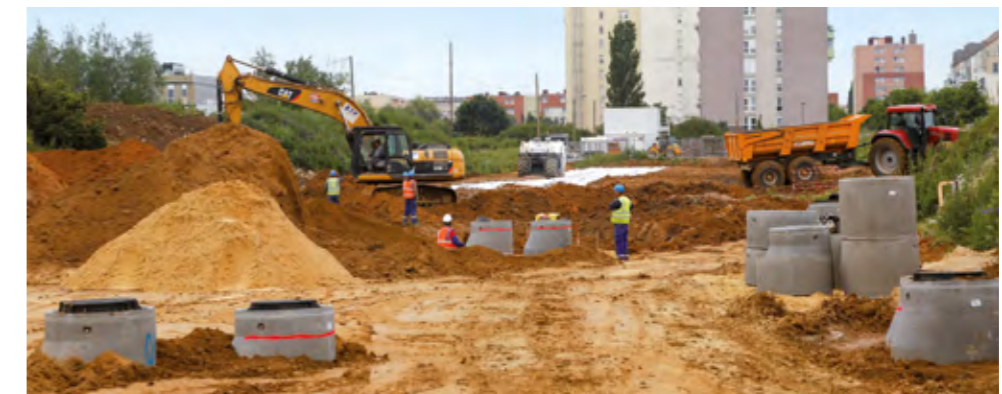
Pose de regards de visite.
