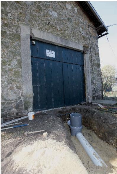
Les culottes de raccordement sont constituées du **même matériau** que la canalisation principale ou du branchement.
